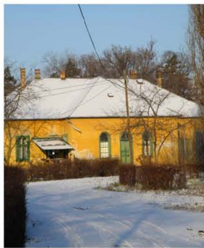
40. ábra V. sz. telep kúriaépülete
