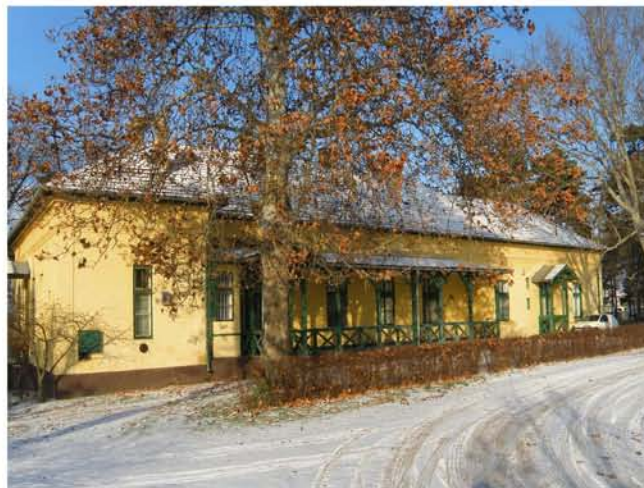
43. ábra II. sz. telep kúriaépülete
